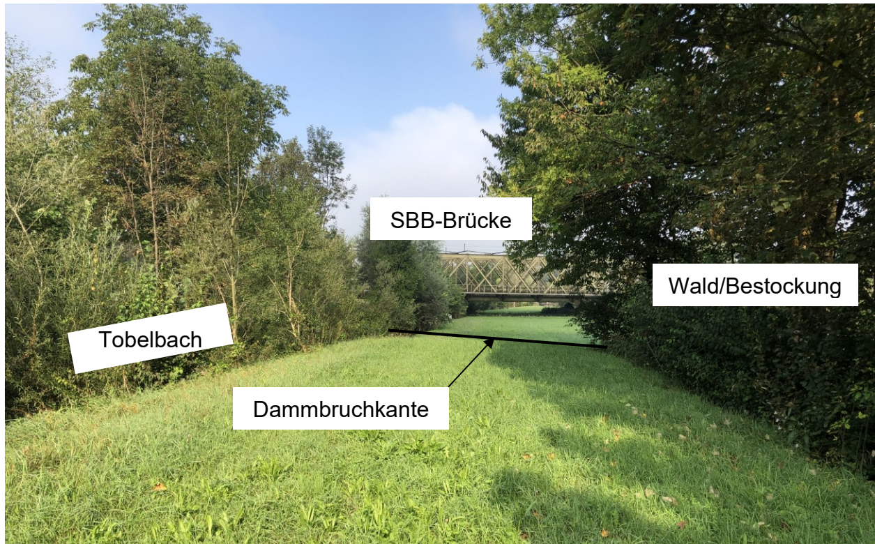
Abbildung 11: Foto; Standort Damm in Blickrichtung Fließrichtung Thur zwischen Tobelbach, Thur und SBB-Eschikoferbrücke
