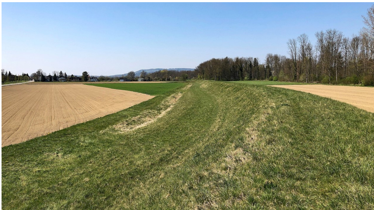
Abbildung 2: Damm Hinterwiese mit Binnenkanal
