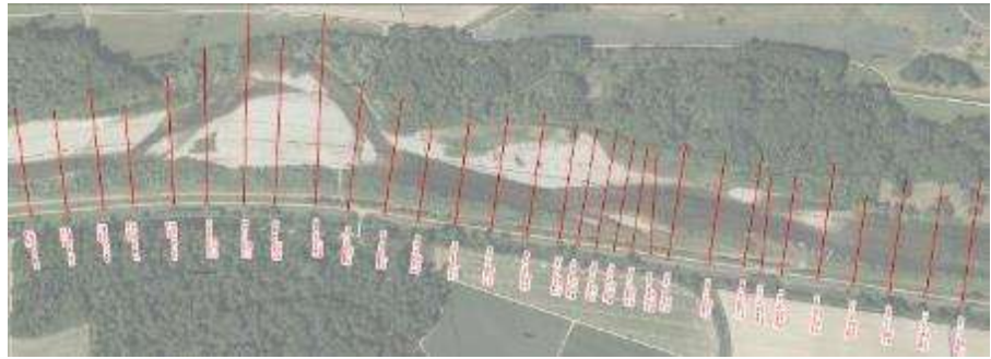
Abbildung 50: Aufweitung Schaffäuli im Jahre 2013. Gut sichtbar sind die Strukturen (Bänke und Fliesswege) im unteren und im oberen Bereich der Aufweitung. Fliessrichtung von rechts nach links.
