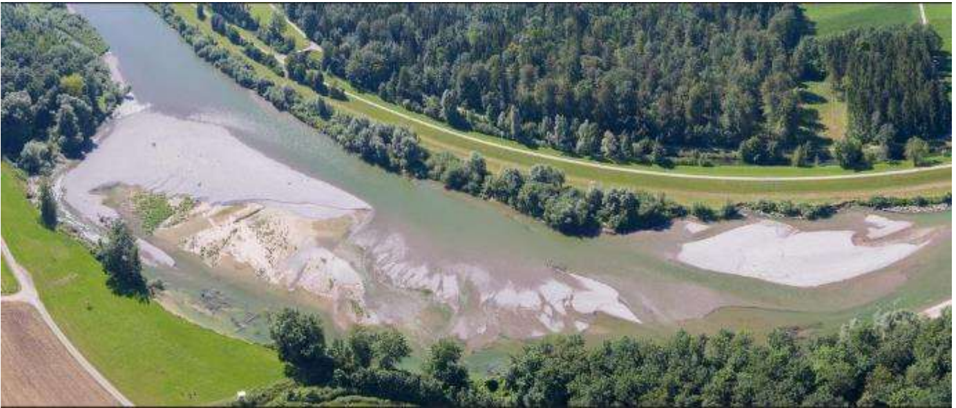
Abbildung 7: Die zusammen mit den Massnahmen für den Hochwasserschutz bereits revitalisierte Thur im Abschnitt Schaffäuli zwischen Frauenfeld und Niederneunforn im Jahr 2016 [5]
