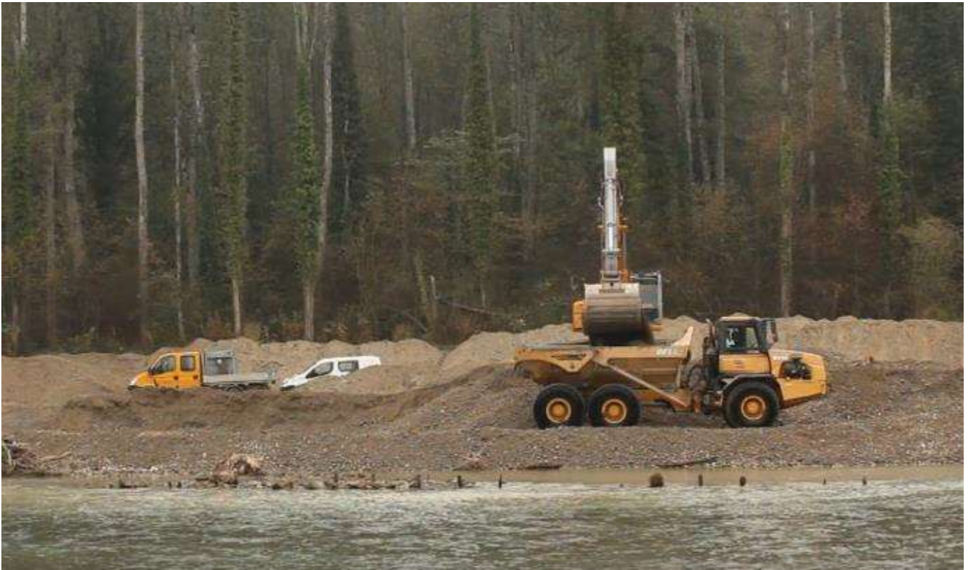
Abbildung 46: Bauarbeiten Etappe 2 für die Thurauen im Kanton Zürich [10]
