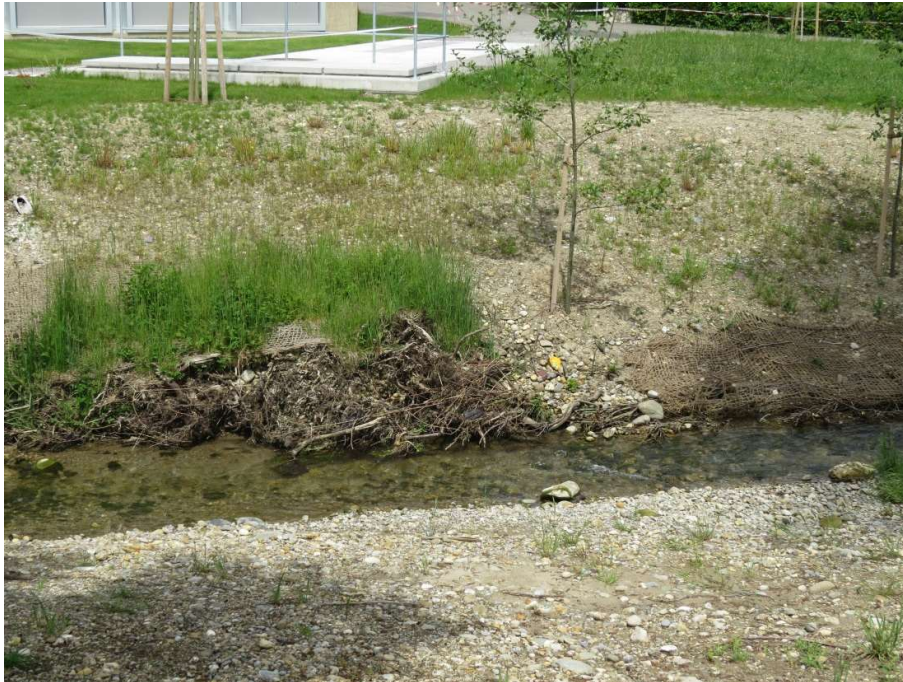
Abbildung 27: Mit Wurzelstöcken gesichertes Ufer, so können Fischunterstände geschaffen werden [Hunziker Betatech AG]
